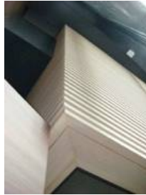
1階風除室吹抜部ルーバー
