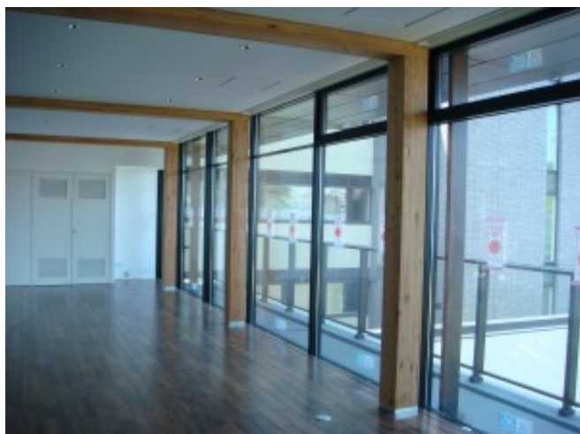
RC造＋一部木造 柱・梁にカラマツ集成材を使用
