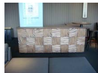
腰パネルヒノキ集成材: 波形加工)
