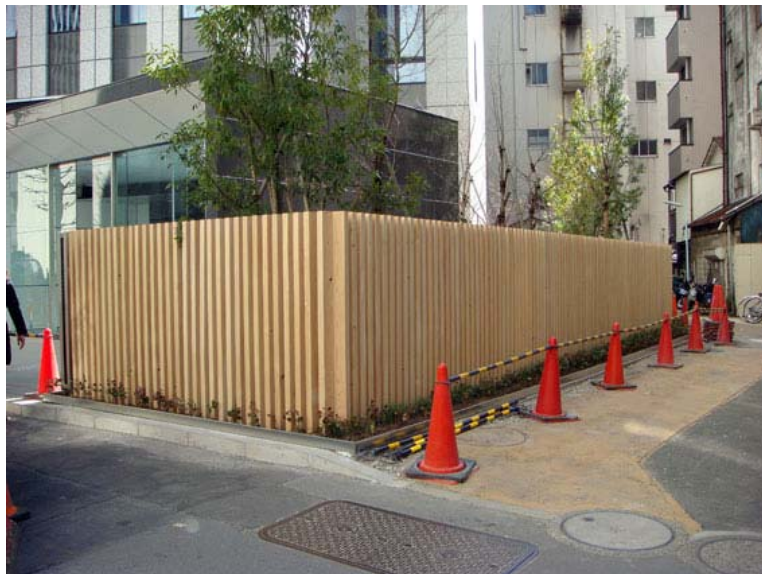
外構フェンス
