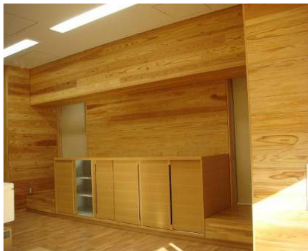
保育室の壁に スギ無垢材を使用
