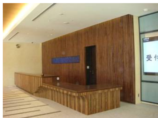
1階フロントカウンター・壁面リブ (スギ集成材)
