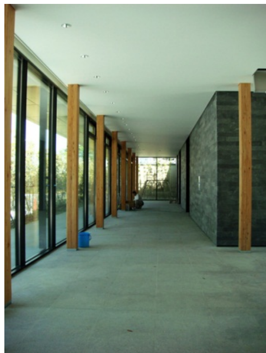
RC造＋一部木造 柱・梁にカラマツ集成材を使用
