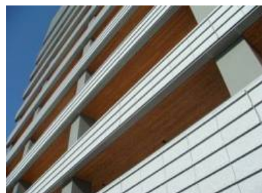
6~14階バルコニー軒天 (スギ縁甲板)
