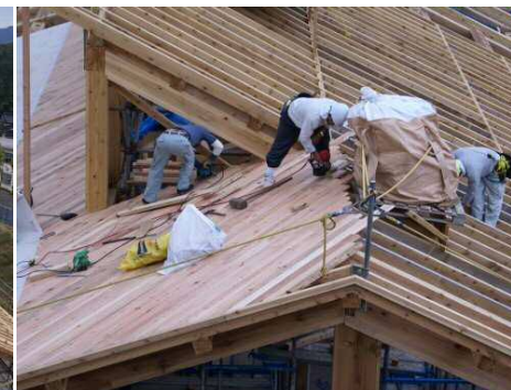
屋根野地板（アップ）
