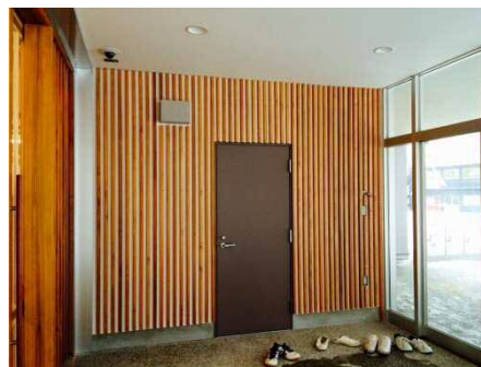
玄関前物置の壁仕上げ
