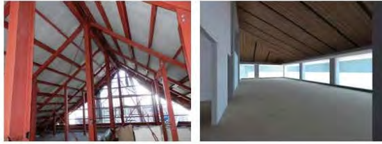
在来工法の場合、複雑化する天井下地類
