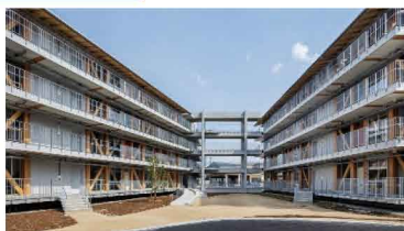
木造建築の風が吹いている！ 全国初「あrawashi」4階建県営住宅
