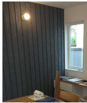
ソمامチ開発の外壁材「カラマツT&Tパネルを試験的に内装施工。施工性など改良する。」
